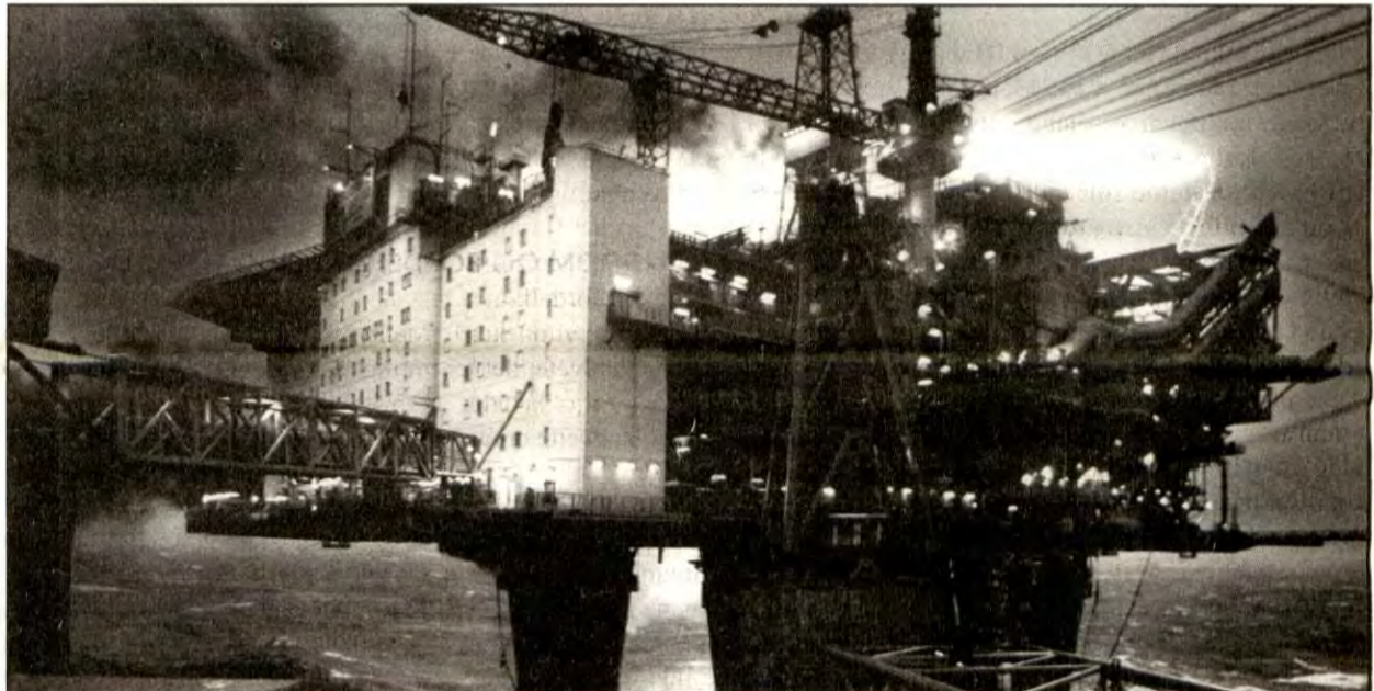
Bildet: Oljeplattformene i Nordsjøen har pumpet opp den oljen som nå gir det norske borgerskapet mulighet til internasjonal ekspansjon
