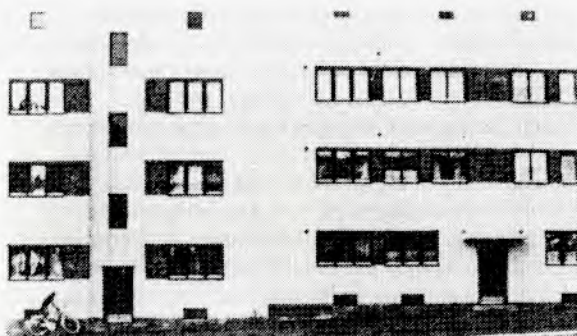
Åsengt. 24b 1931, arkitekt O. Øvergaard. Første kommunale leiegård som benyttet plaststøpte betongelementer. Funksjonalismen førte med seg nye standardhevinger til disse 2-3 roms leilighetene: Sentralfyr, felles varmtvannsforsyning, badekar og vaskerom i forbindelse med »laboratorie»-kjøkkenet.
