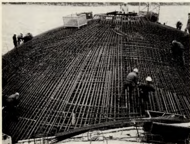
Armering på toppen av en lagercelle på Statfjord C, Gandsfjorden. FOTO: STATOIL
